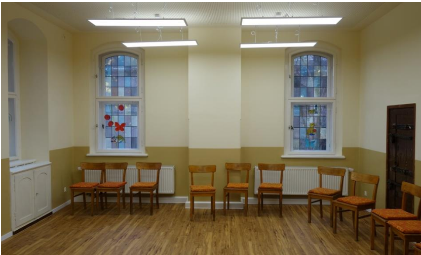
Frisch saniertes Turmzimmer in der Apostelkirche
